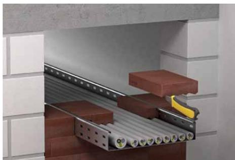
Montagem dos blocos PYROPLUG® em abertura com passagem de eletrocalha. Eles são facilmente cortados com estilete para se adaptarem à instalação.
